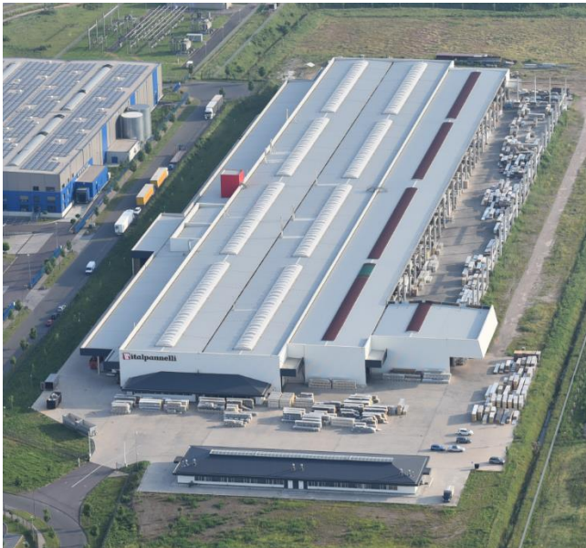
Das Italtanelli-Werk nahe Trier (@Italtanelli)
